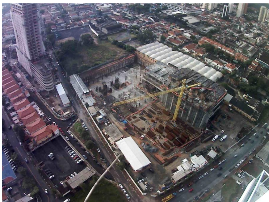
Foto do Canteiro de Obra EZ Towers dia 16 de janeiro de 2013
